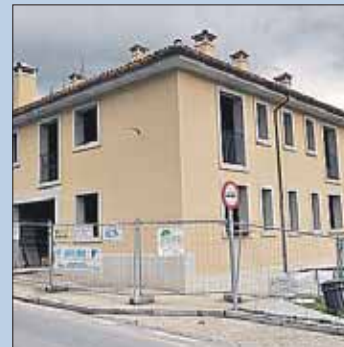
Edificio de San Marcos. / KAMARERO
