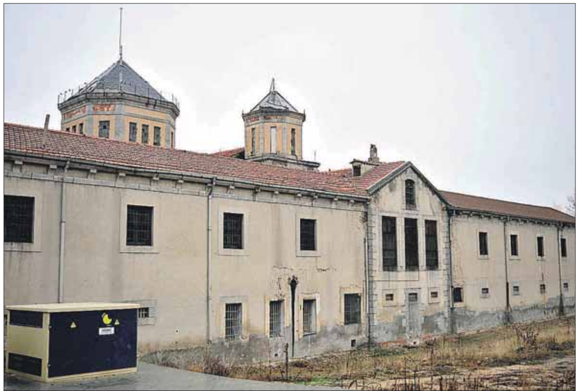
La residencia de estudiantes se ubicará en la nave posterior de la antigua prisión de Segovia. / JUAN MARTÍN
