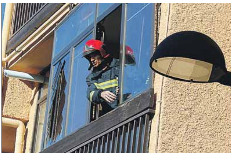
Un bombero observa los daños causados en el ventanal por la explosión. / M.G.
