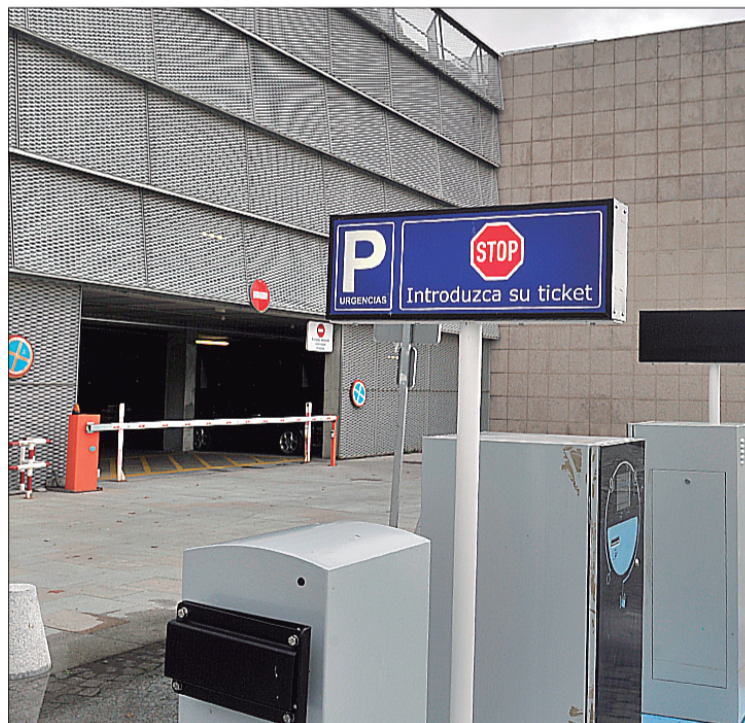
Control de entrada y salida de vehículos a la zona de Urgencias. / KAMARERO
