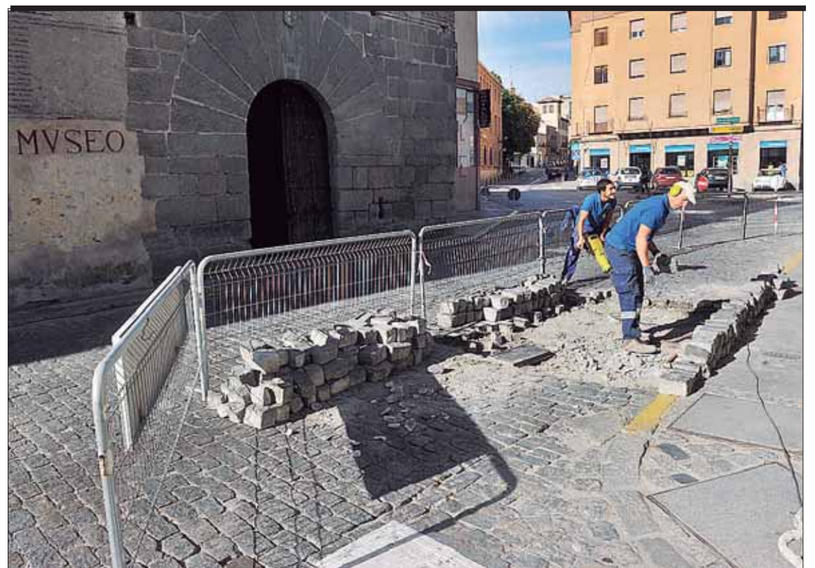
Corte en San Agustín. El Ayuntamiento inició ayer las obras de arreglo y reparación de un bache en la calzada de la calle San Agustín; a la altura de la calle Donantes de Sangre. Los trabajos se prolongarán hasta el próximo domingo. Ese día quedarán abiertos al tráfico los dos sentidos de circulación de la calle. / FOTO: K
