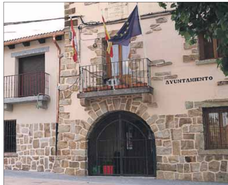
El Ayuntamiento de La Losa trabaja en la reducción de su deuda. / EL ADELANTADO
