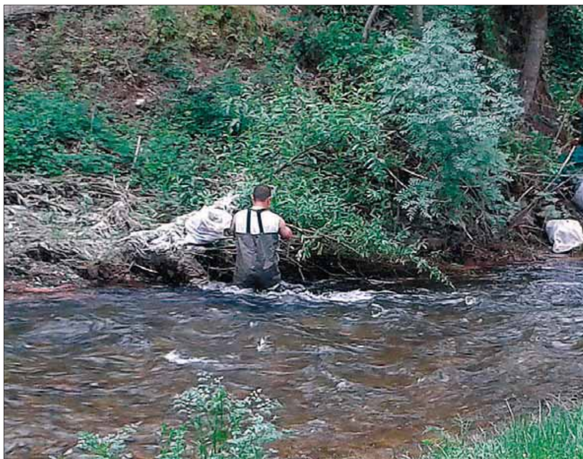
Uno de los trabajadores, durante las labores de limpieza realizadas en el río. / EL ADELANTADO
