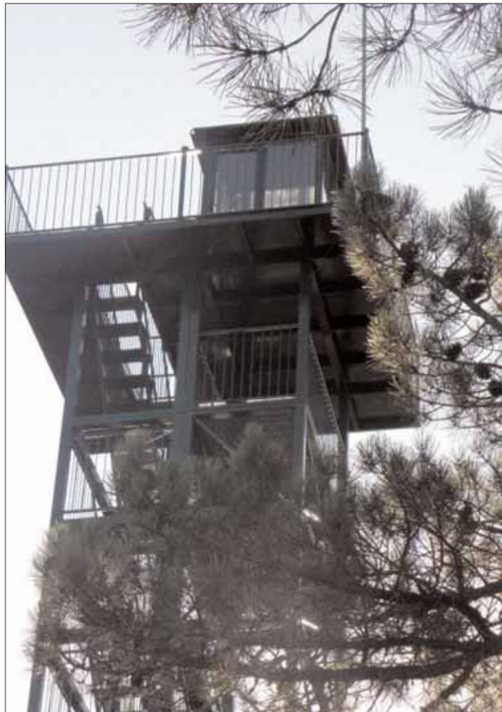
Una de las torretas de vigilancia repartidas por toda la región. / ICAL
