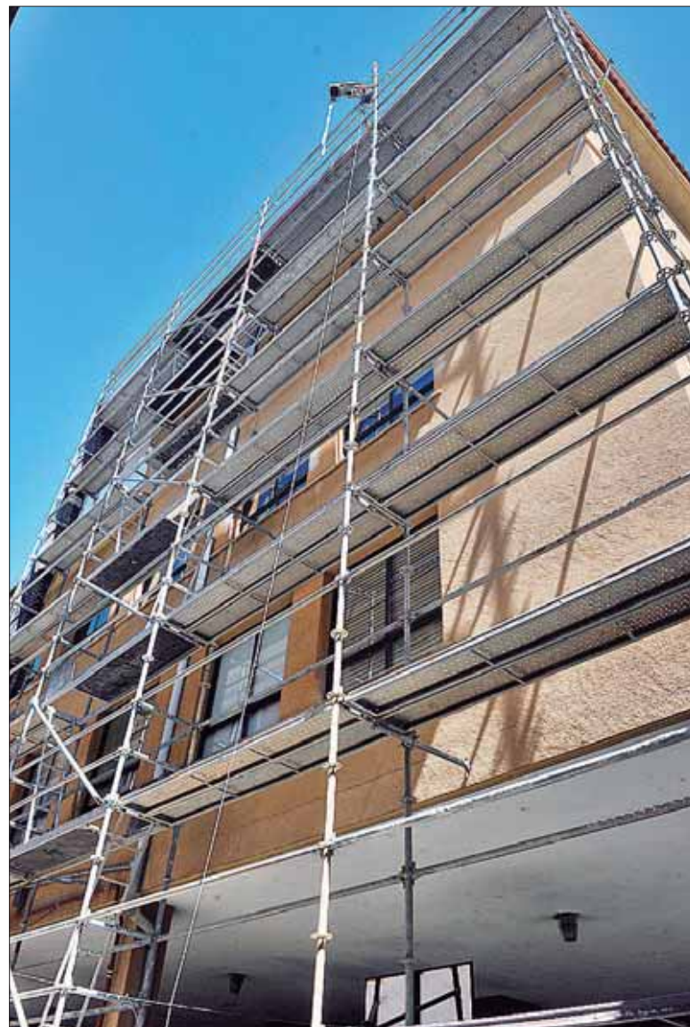
Los trabajos contratados por la Junta están ejecutándose en el 'Domingo de Soto'. / K.
