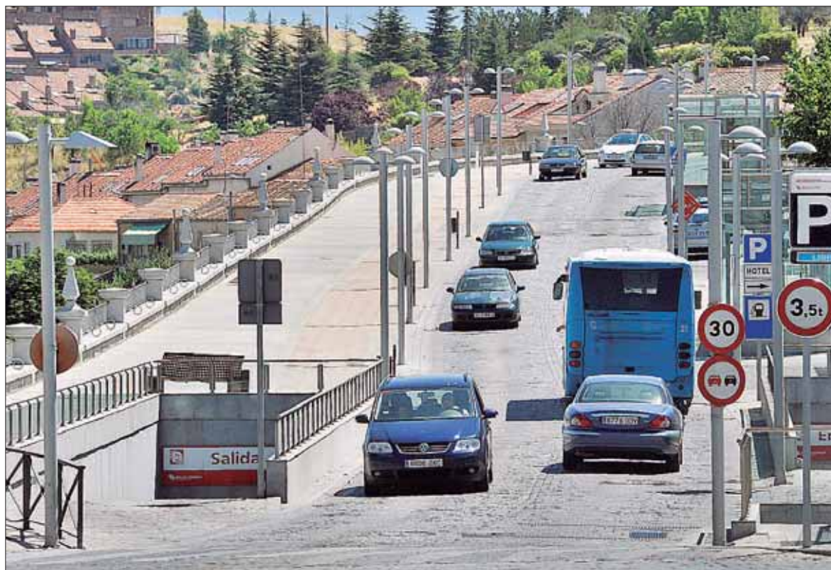
El tramo adoquinado de la avenida de Padre Claret permanecerá en obras durante el mes de agosto. / KAMARERO
