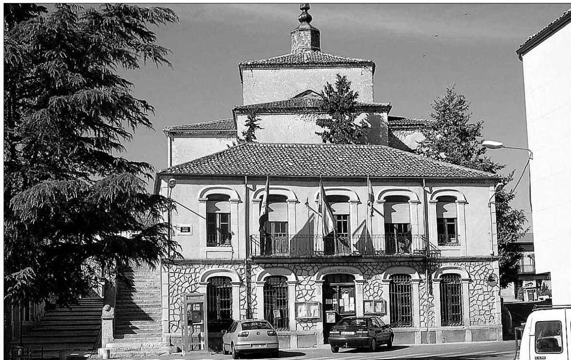
El Ayuntamiento de Olombrada, en imagen de archivo, se halla en ruinas desde 2007. / EL ADELANTADO
