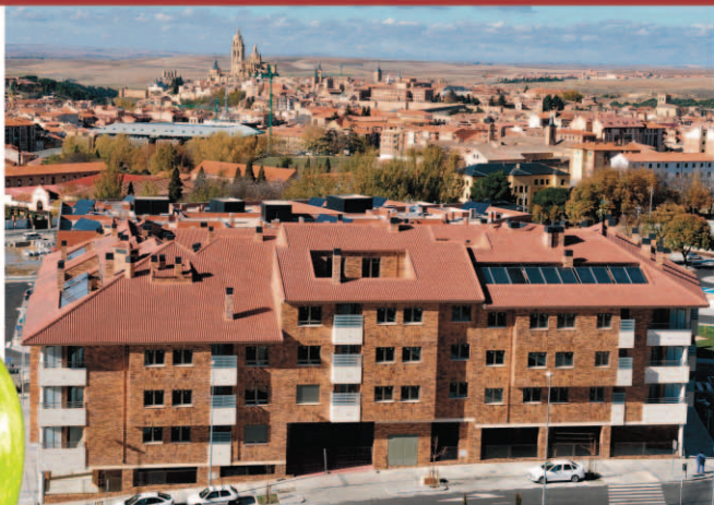
"MANZANA GOLDEN", Edificio de 86 viviendas, locales, garajes y trasteros.
