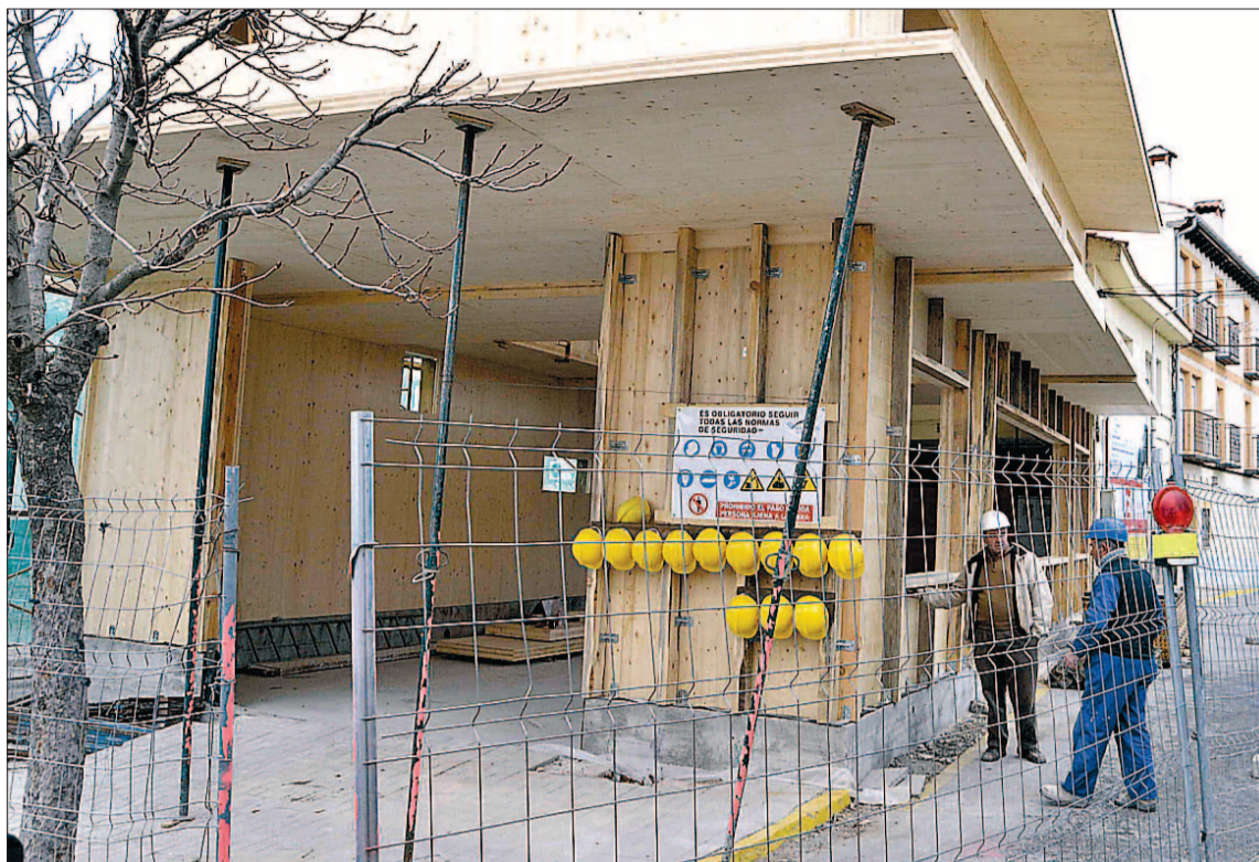
El Centro Joven de San Cristóbal de Segovia se encuentra aún en construcción. /ALBERTO BENAVENTE
