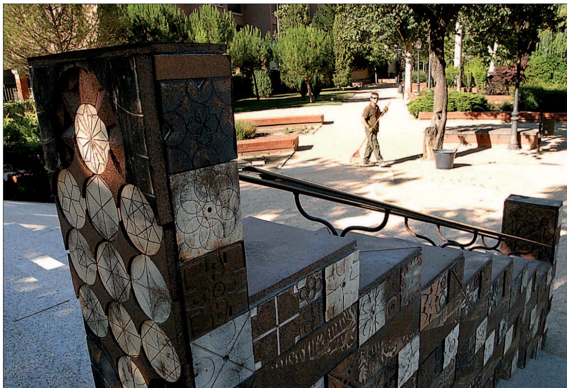
La nueva barandilla está en línea con los murales cerámicos que hay en el interior del jardín desde 1995. / EL ADELANTADO
