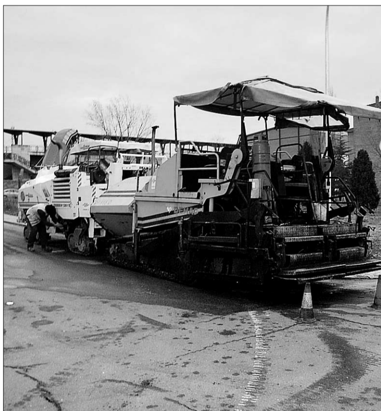
El Ayuntamiento invertirá 157.000 euros en el plan de asfaltado. / KAMARERO
