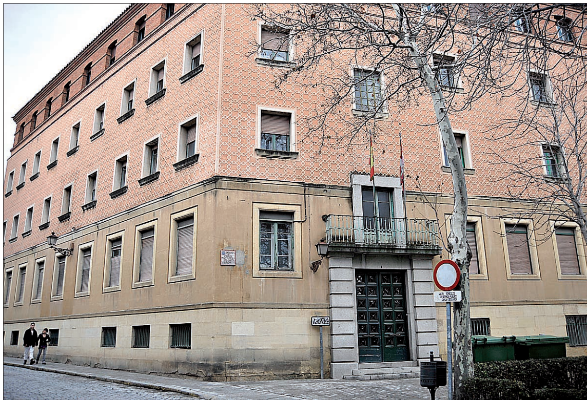
El edificio del Hospital Policlínico permanece cerrado, fuera de servicio, desde noviembre de 2008./KAMARERO
