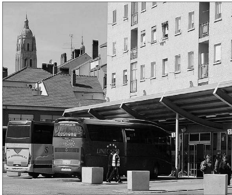
La marquesina permanece anclada a la fachada del edificio. //JUAN MARTÍN
