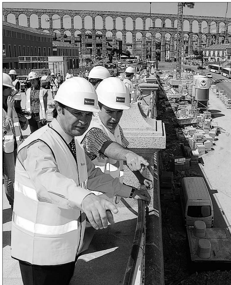
Arahuetes comprobó el estado de las obras de reurbanización de la avenida. // J.M.
