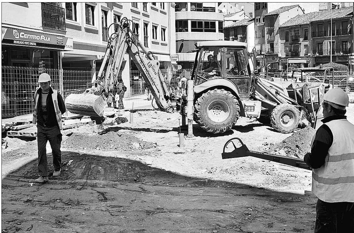
Obras que ejecuta Volconsa en la calle de José Zorrilla. La imagen es del pasado sábado. / KAMARERO
