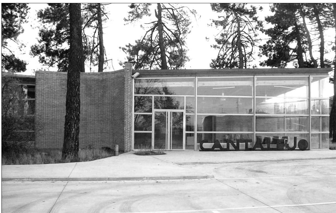
Vista panorámica de la futura estación de autobuses de Cantalejo. / CHUS VALERIO
