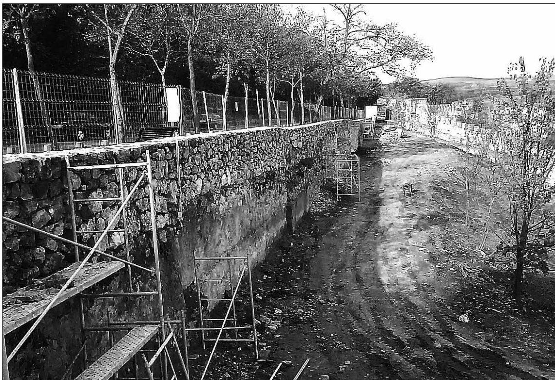
Las obras han servido para limpiar y desbrozar la parcela y realiza un nuevo cerramiento (a la izquierda). / EL ADELANTADO
