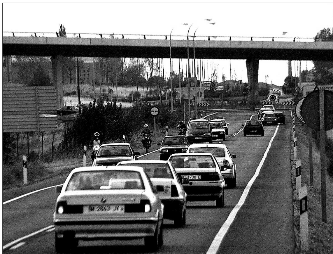
La carretera CL-601, en la fotografía, es el eje junto al cual transcurriría la futura línea de tranvía. / JUAN MARTÍN
