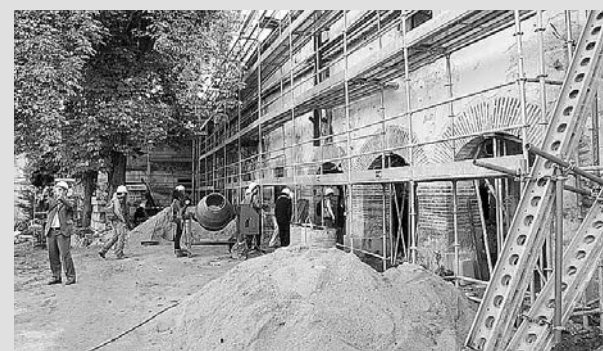
EDIFICIO CULTURAL. El antiguo edificio de Fundación se destinará a acoger todo tipo de actividades culturales. Un plan de emergencia y un millón de euros permitirán mantener su estructura original.
