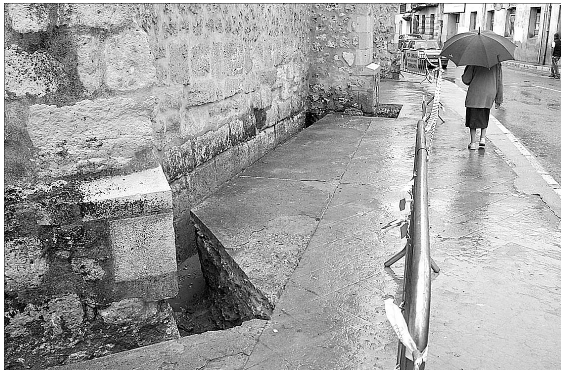
Zanja abierta durante los trabajos para la eliminación de las humedades de las naves laterales. / GABRIEL GÓMEZ
