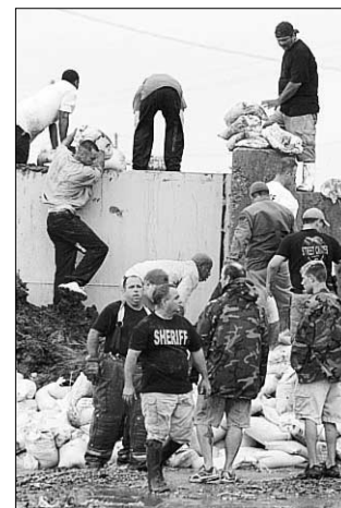
Los diques cumplieron su labor.
