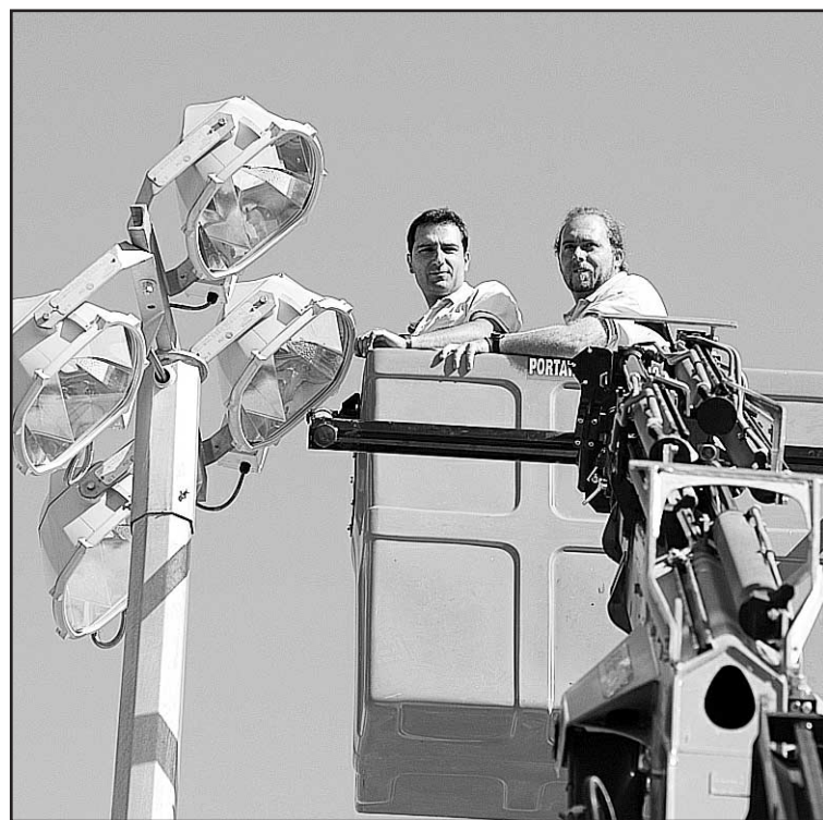
Dos de los trabajadores de Hnos. Sanz Álvarez arreglando un foco de la pista central
