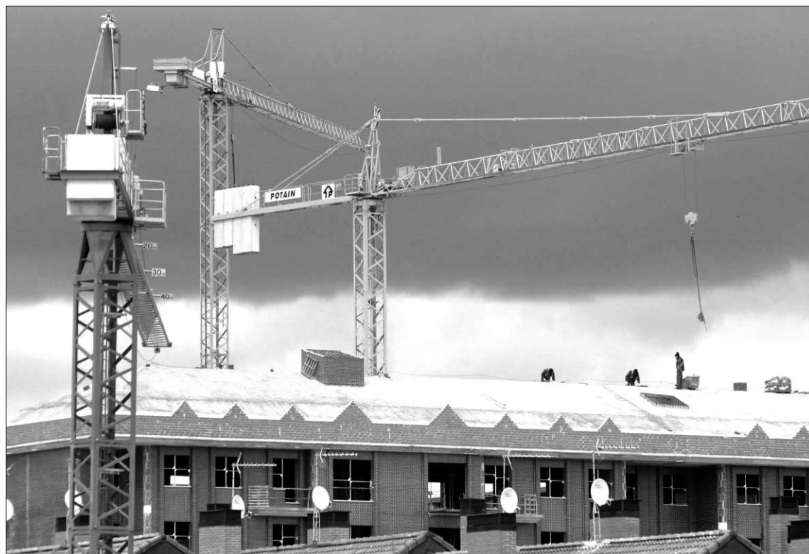
Imagen de varios edificios en construcción. / LETICIA PÉREZ (ICAL)
