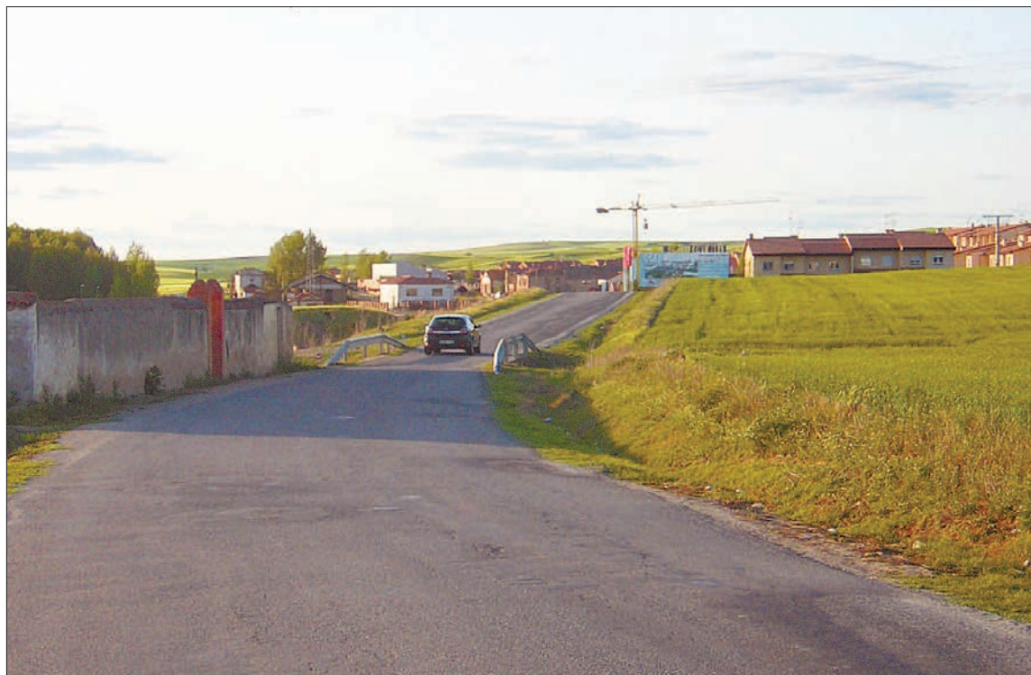
La situación del actual tramo se considera el principal motivo de aislamiento entre el pueblo y los barrios incorporados. / A.P.
