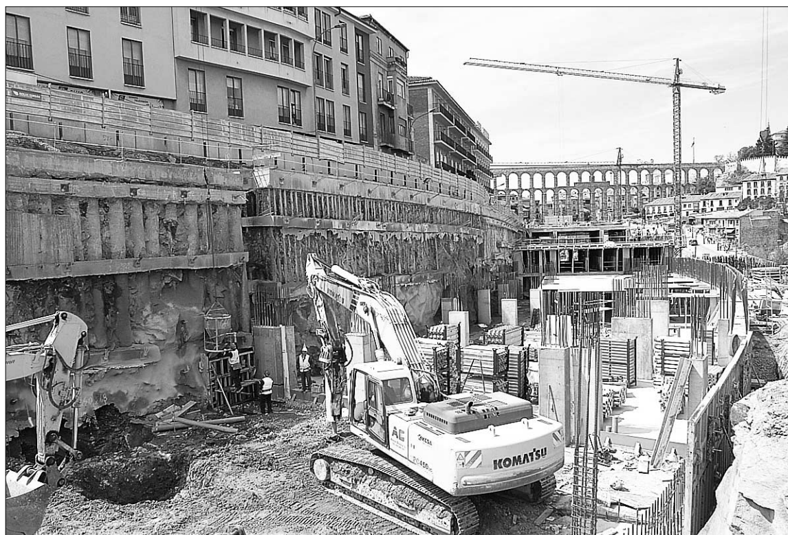
Las máquinas continúan trabajando sin descanso para que las obras continúen cumpliendo los plazos previstos. / J. MARTÍN
