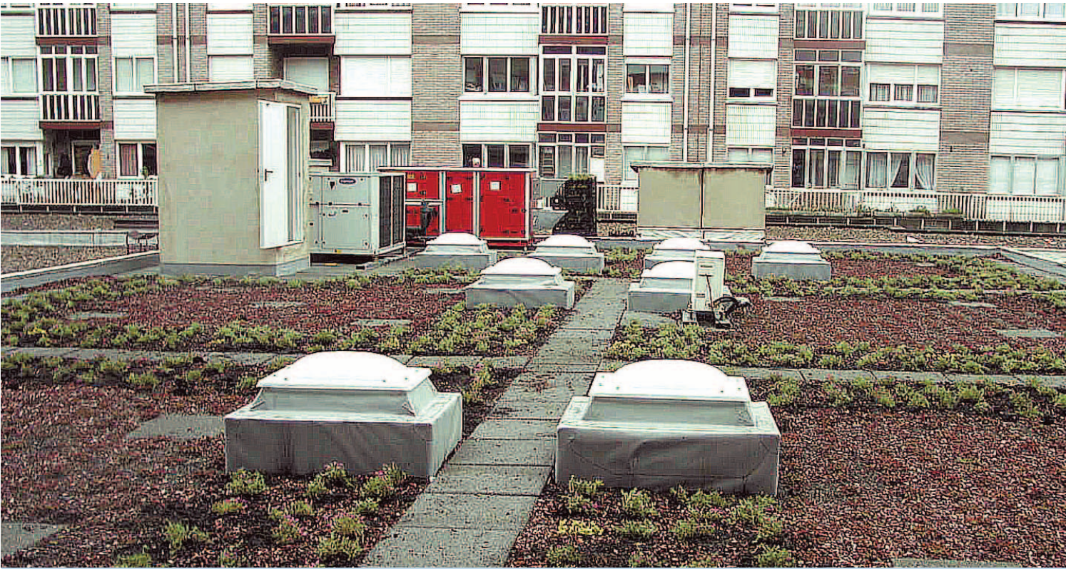
En Salamanca son varios los edificios que albergan plantas en sus terrazas para controlar el dióxido de carbono. / IICAL
