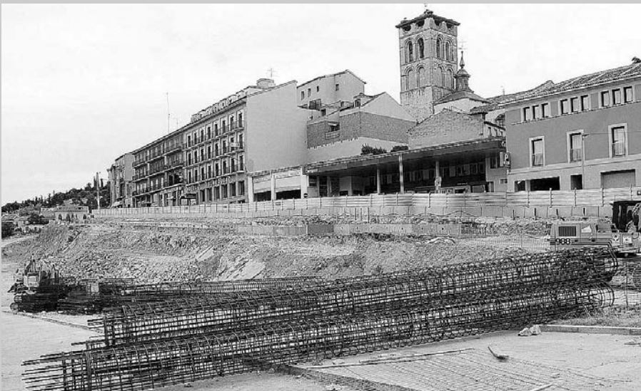
La aparición de roca blanca permitía a comienzos de verano acelerar las obras de excavación, haciendo finalmente innecesarias las voladuras y permitiendo limitarse a la maquinaria pesada. La imagen es de mediados de julio, cuando el avance de las obras era ya notable. / KAMARERO
