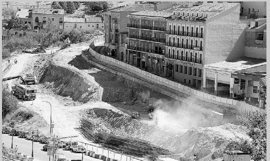
En septiembre de 2007, la fase de excavación del aparcamiento superaba el 50 por ciento de los trabajos; el desmante se veían avanzar a buen ritmo y la maquinaria pesada incrementó su presencia en la zona, para habilitarla cara al inicio de la construcción. / FERNANDO PEÑALOSA
