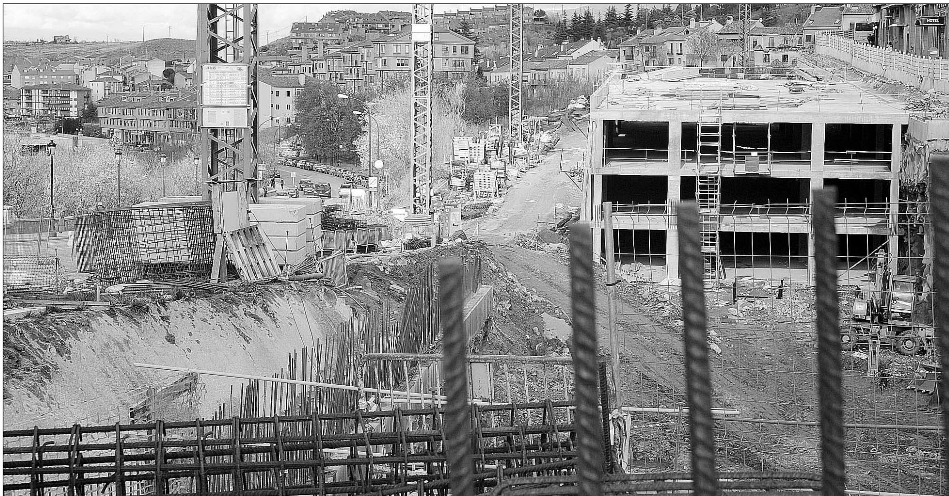
En la estructura ya construida se aprecian las tres plantas con las que contará el aparcamiento, con más de medio millar de plazas, de las que 440 serán de rotación. / KAMARERO
