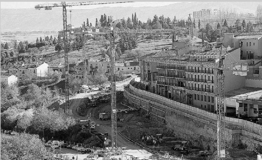
En noviembre, a mediados de mes, comenzaba la instalación de las grandes grúas que aún pueden verse en la zona en obras y, prácticamente concluida la excavación, comenzaba la fase de construcción de la estructura, las tres plantas del futuro aparcamiento. / FERNANDO PEÑALOSA
