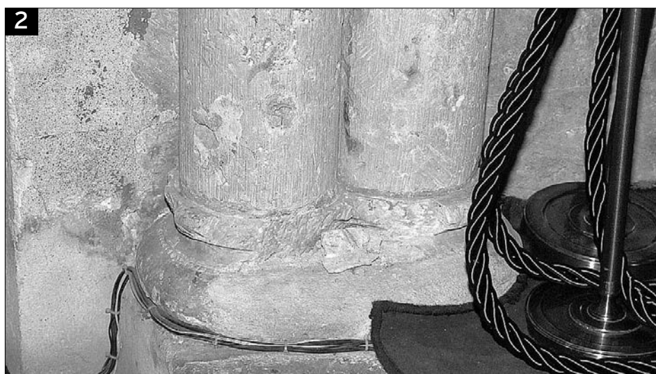
1. La techumbre del ábside presenta grietas y humedades que deslucen el templo y han obligado a colocar cerchas para consolidarla. 2. El mal de la piedra provoca constantes desprendimientos de trozos de capiteles incluso en el interior de la iglesia. 3. El párroco Andrés de la Calle señala algunas de las zonas más castigadas del atrio. / FOTOS: FERNANDO PEÑALOSA
