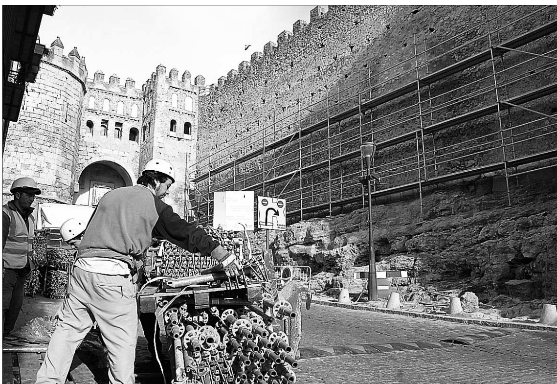
Las obras de restauración de la Muralla han comenzado en la zona más próxima a la Puerta de San Andrés. / JUAN MARTÍN
