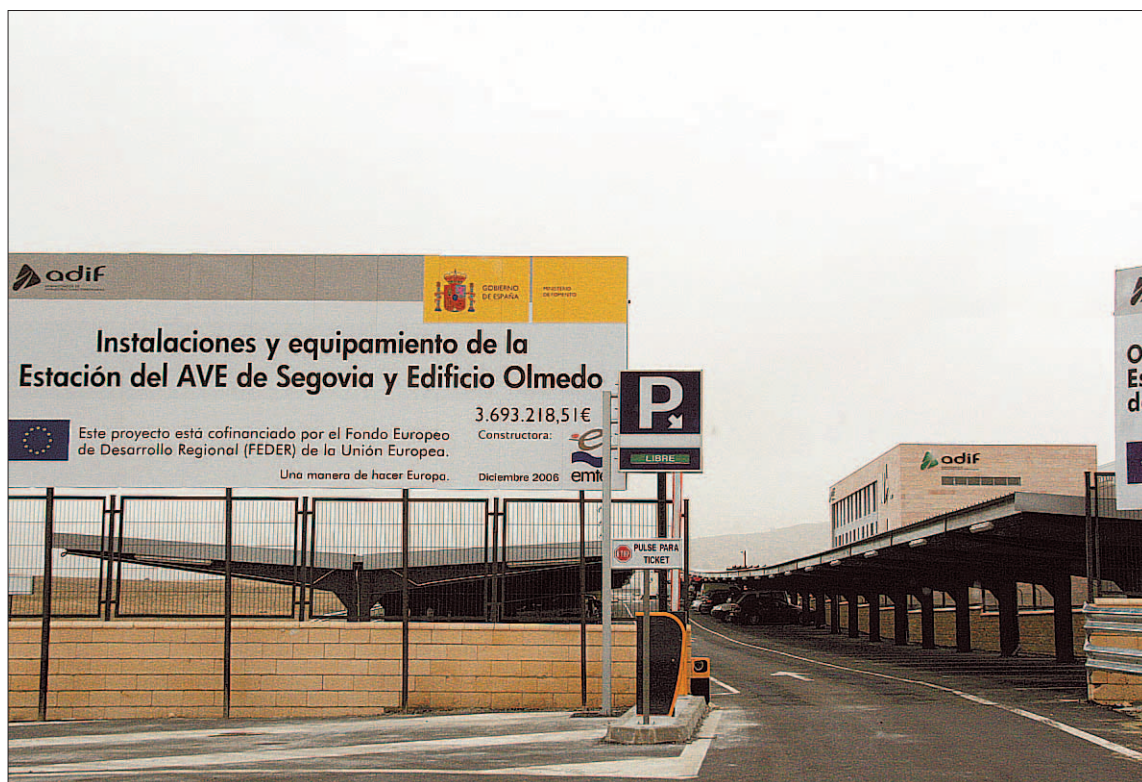
Imagen de la entrada al aparcamiento de vehículos construido en la nueva estación Segovia-Guioimar. / FERNANDO PEÑALOSA
