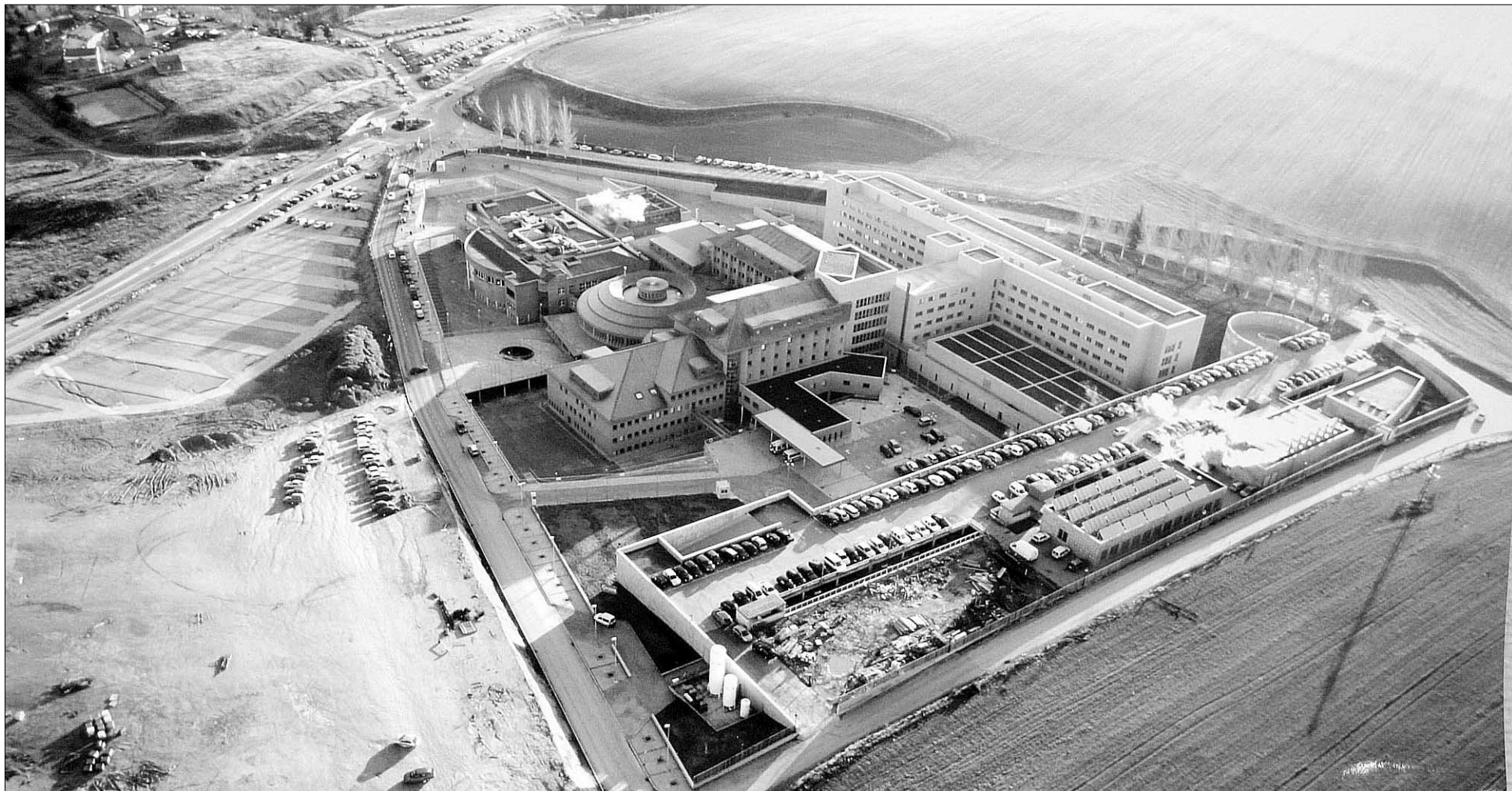
Imagen aérea del Hospital General cuyas instalaciones, servicios y profesionales han sido ofrecidos para desarrollar la formación práctica de los futuros universitarios del campus de la UVA. / JUAN MARTÍN
