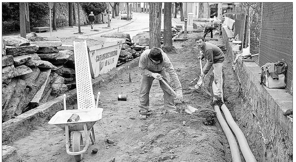
Las obras se están ejecutando en diferentes puntos de la localidad. /P.L.M.
