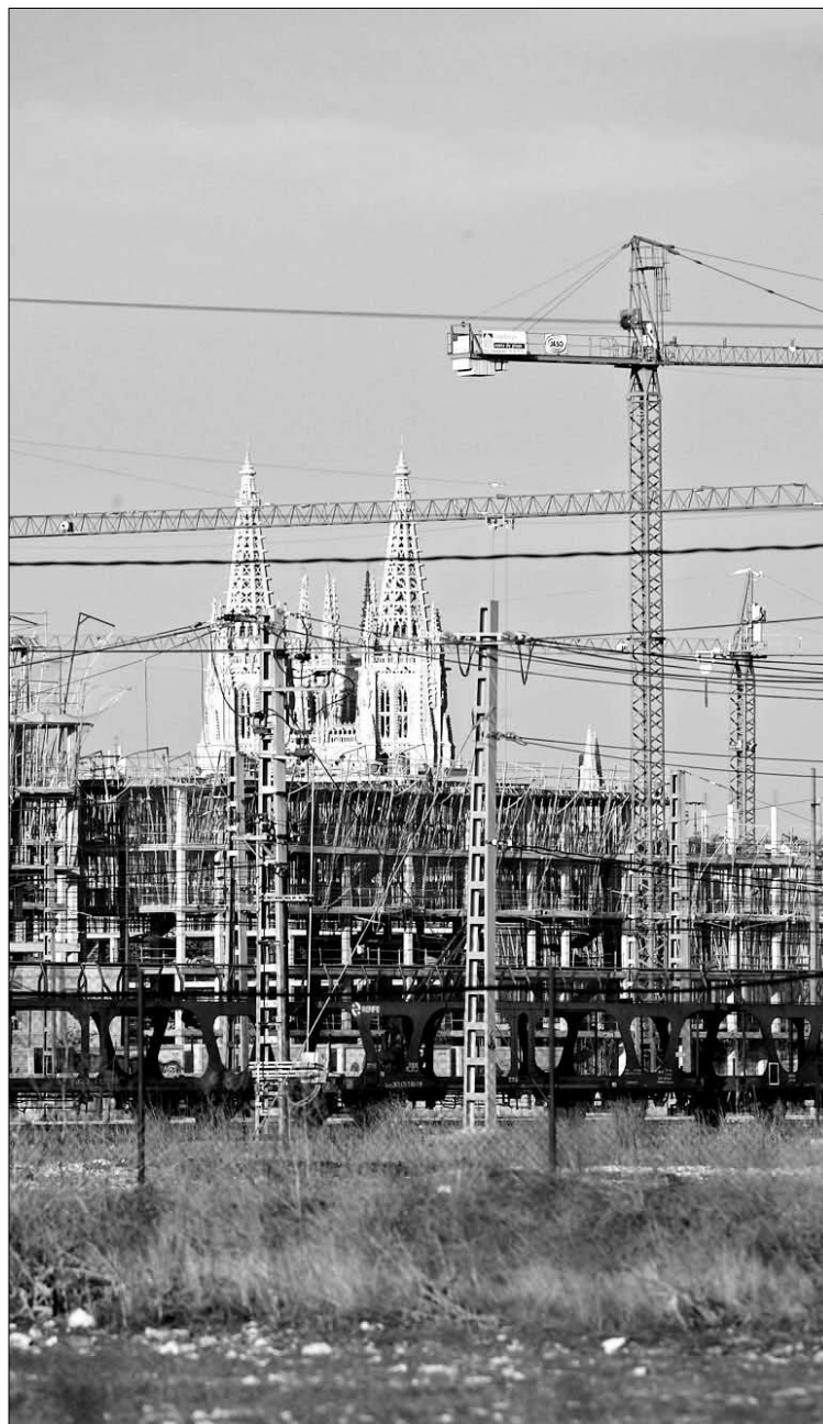
El Euribor puede condicionar la actividad del sector de la construcción. / L.L. ARAICO
