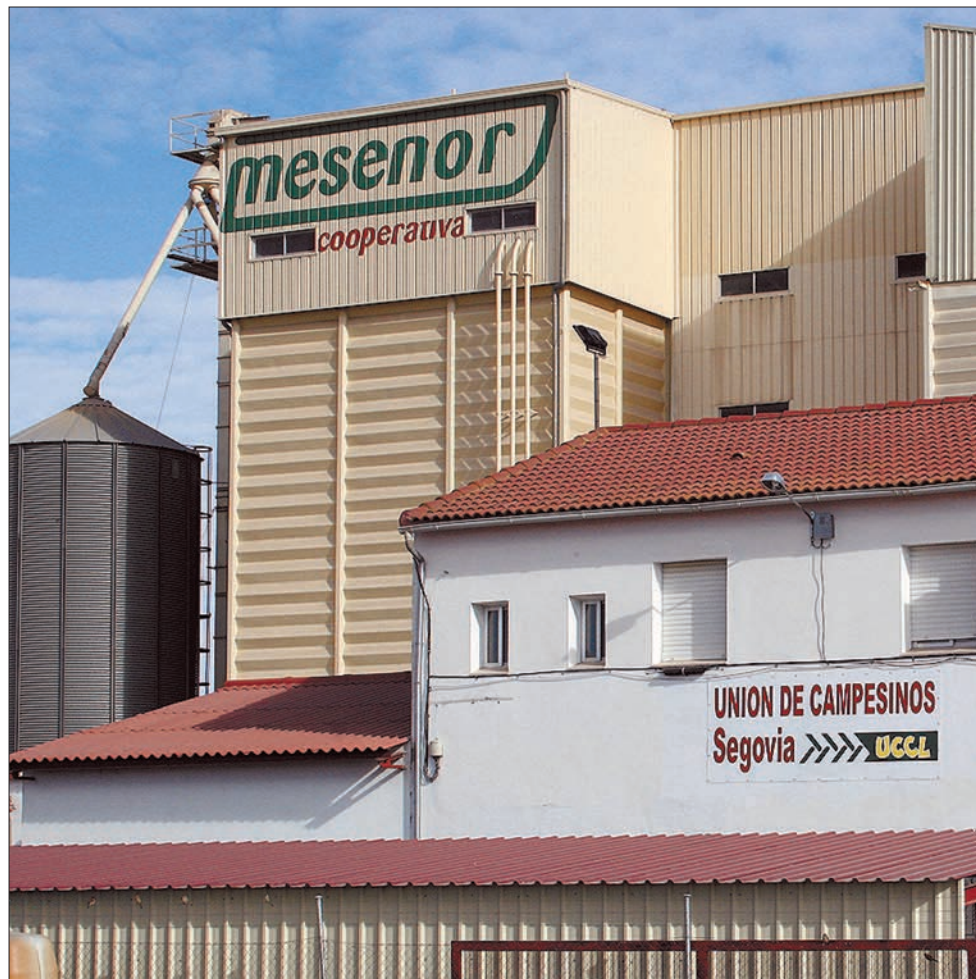
Una vista de las instalaciones de la empresa 'Mesenor'
