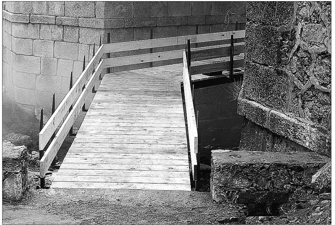
El camino discurre por una nueva pasarela que pasa por debajo del puente de la carretera N-603 / ÁLVARO PINELA
