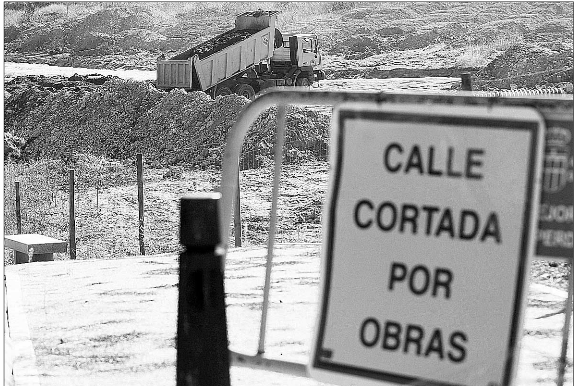
La obra afecta a parte del camino de tierra que fue adecentado con motivo del Plan de Riberas/KAMARERO
