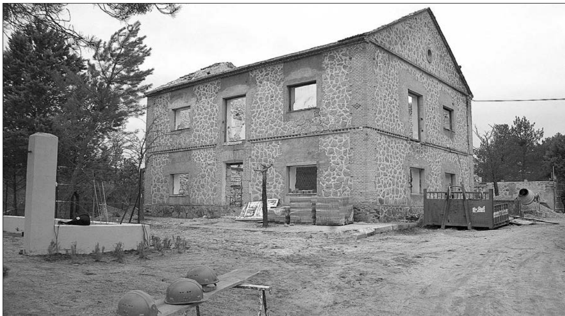
Las alumnas trabajarán en los acabados interiores e instalaciones de la Casa Forestal de Fuentemacanda./GABRIEL GÓMEZ
