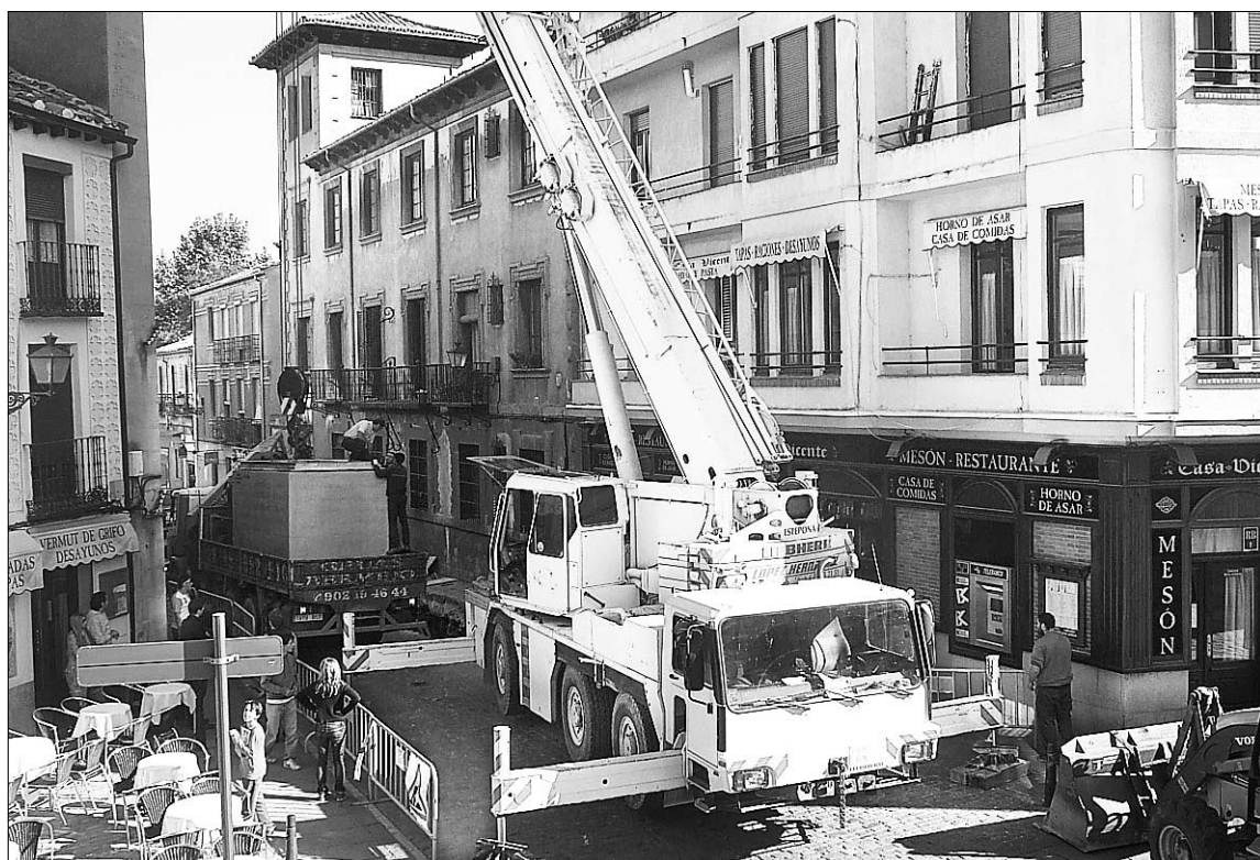
Con la ayuda de una gran grúa, se colocaron los prefabricados de los contenedores soterrados en la calle Serafín /KAMARERO
