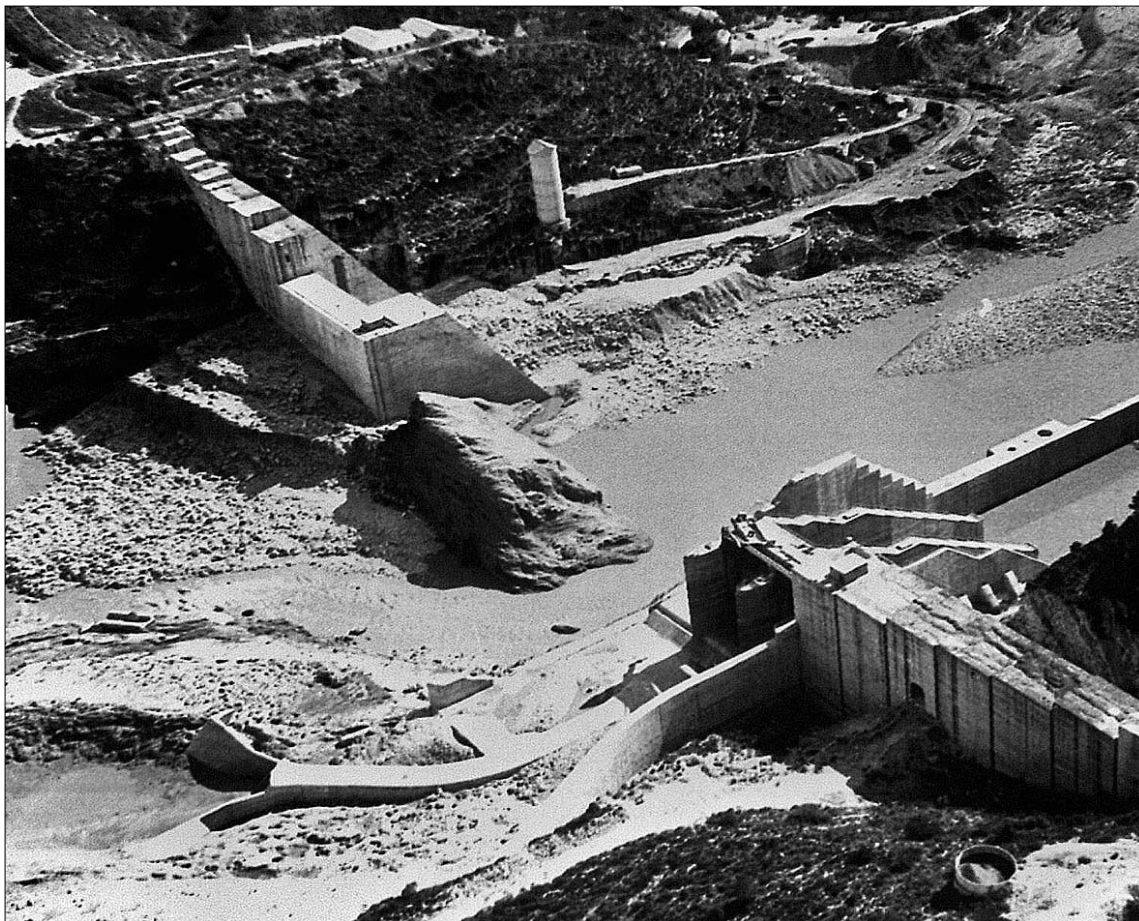
La rotura de la presa causó nueve muertos y unas cuantiosas pérdidas económicas. / EFE
