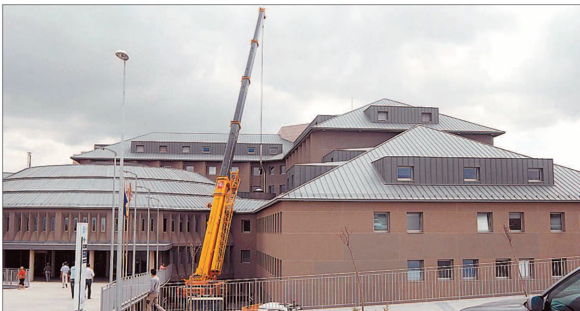
El imán de la resonancia fue trasladado al interior del hospital por el aire, con una grúa de brazo largo/KAMARERO
