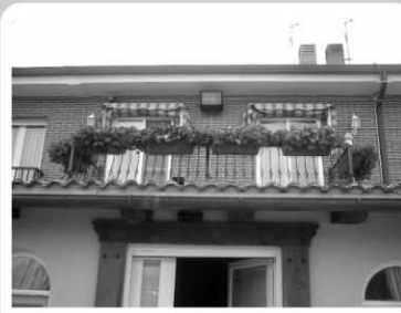
Detalle de la fachada
