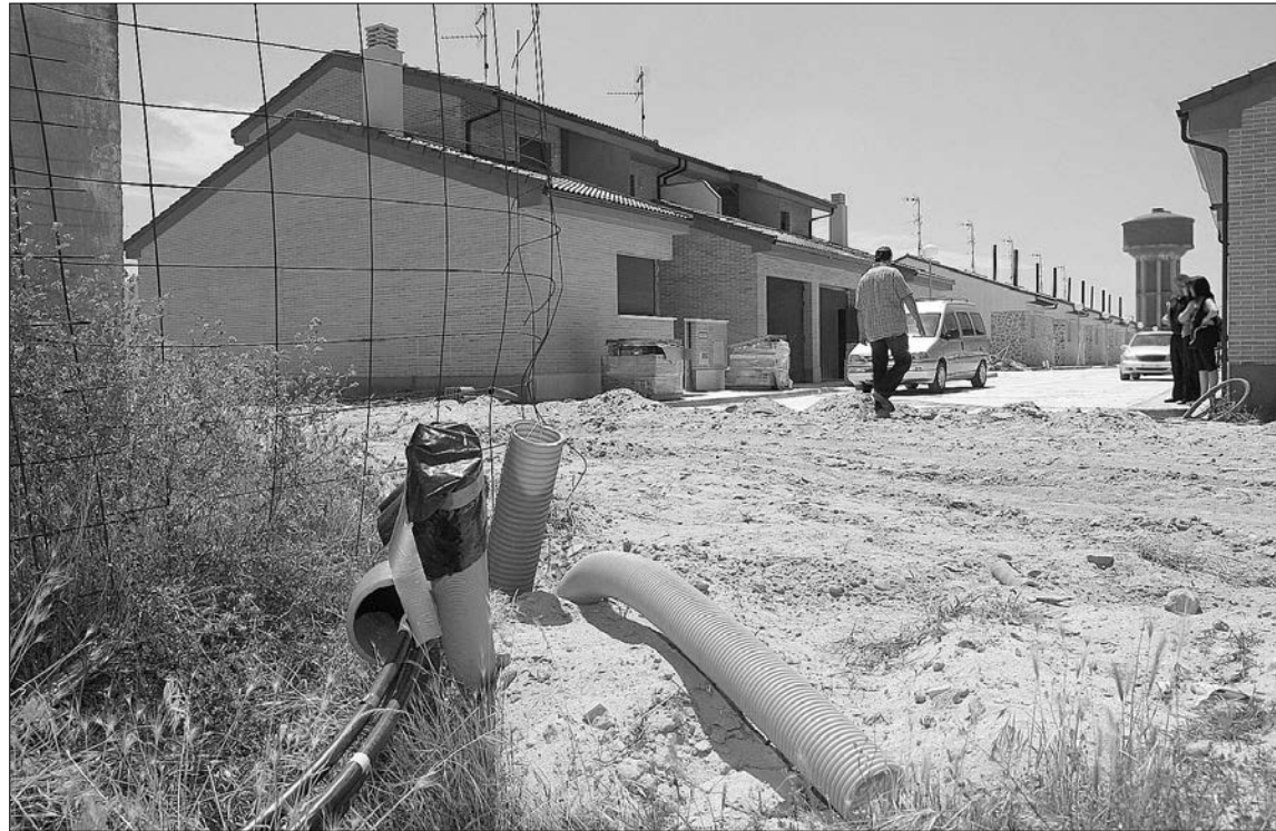
Viviendas afectadas por la falta de suministro eléctrico. / GABRIEL GÓMEZ
