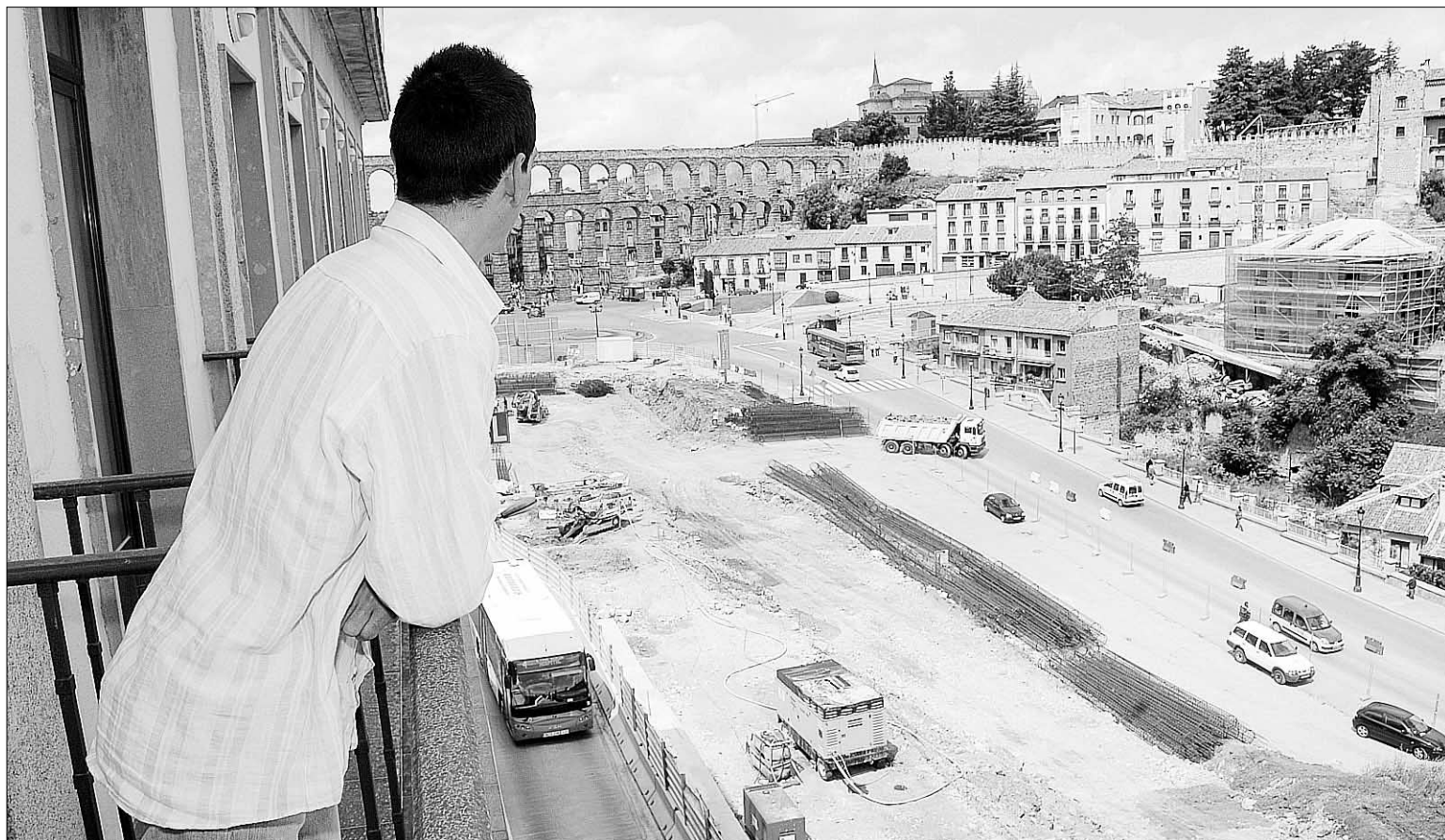
Las increíbles vistas del Hotel Acueducto se funden con el polvo de la obra. Los clientes protestan y sus responsables, resignados, piensan que el aparcamiento es necesario. /KAMARERO
