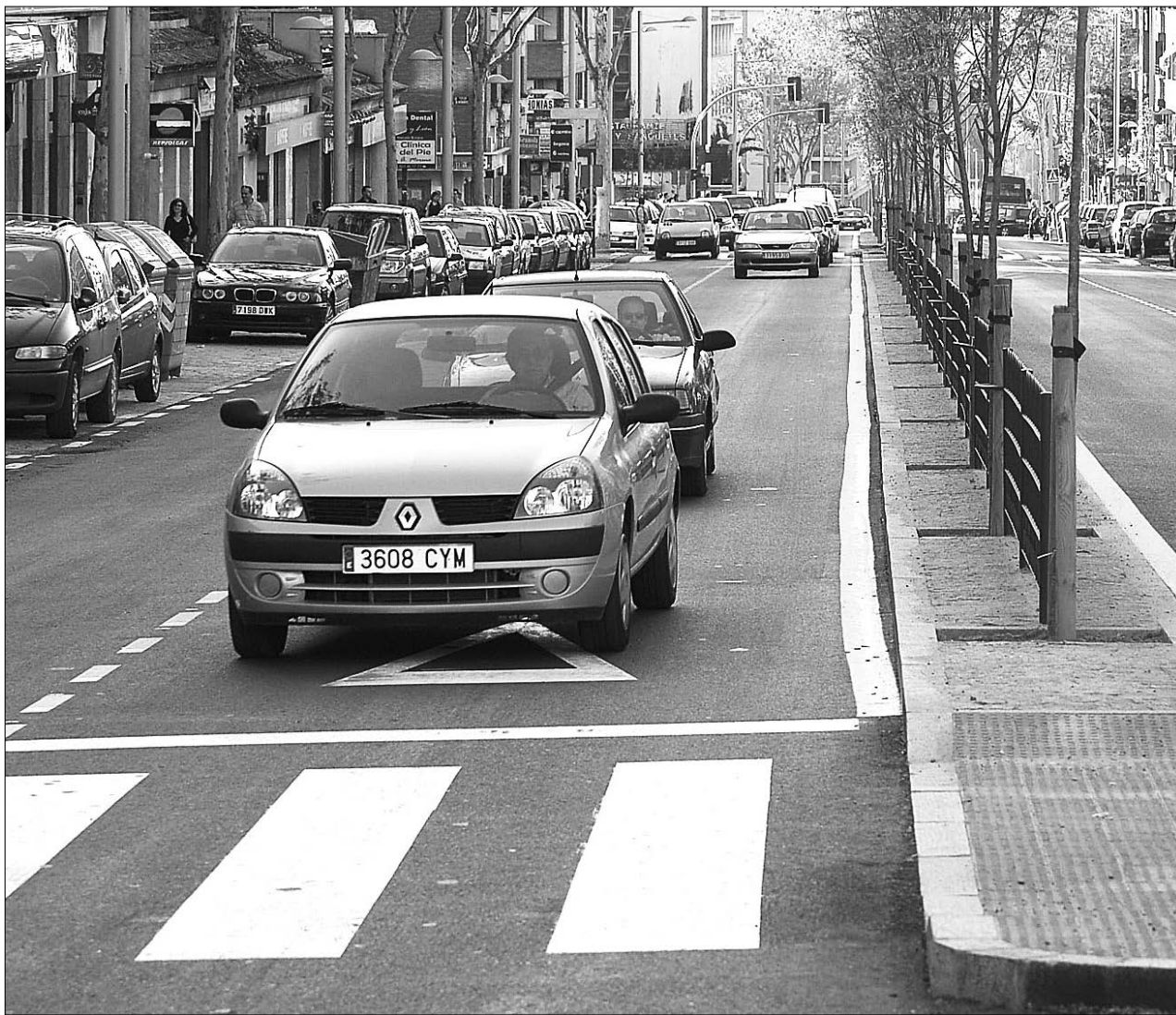
Además de la renovación del aspecto exterior del Camino Nuevo, las obras que ahora concluyen han servido para sustituir más de cinco kil
