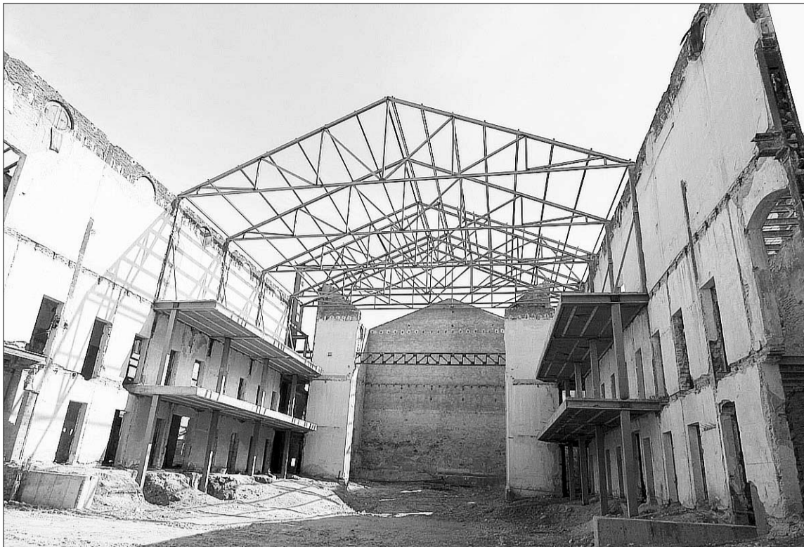
La altura de la cubierta del escenario es hoy 3,15 metros por encima de la que aprobó Patrimonio en 2003/PEÑALOSA
