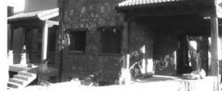
Estructura de madera de 1ª calidad (pino de Valsain) (Pilares forjados, vigas, porches,...)
