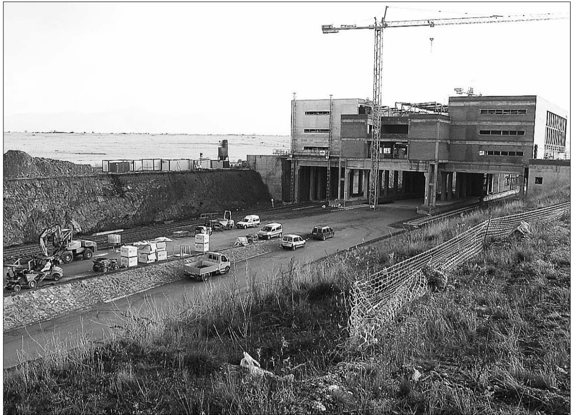
Imagen de la estación del AVE, aún en construcción, a la que se dará acceso a través del nuevo vial. / KAMARERO
