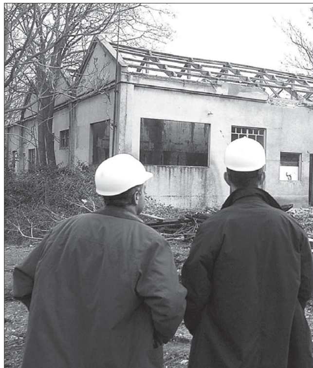
Dos técnicos de la constructora Volconsa contemplan el inicio oficial de las obras, con el derribo
