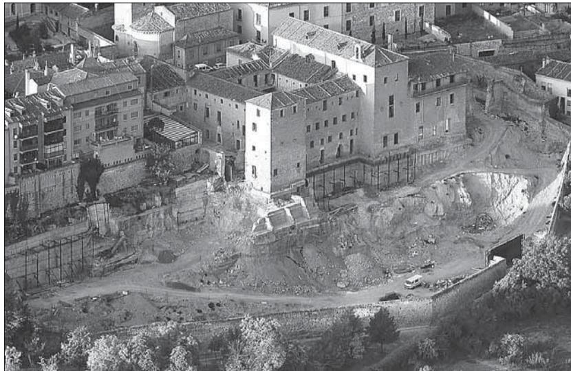
Las obras fueron paralizadas tras el derrumbe de un talud y al detectar un exceso de excavación./JUAN MARTÍN
