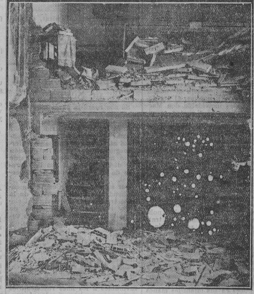
Destrozos causados por la explosión de la bomba en la planta baja de la casa del Sr. Ybarra
