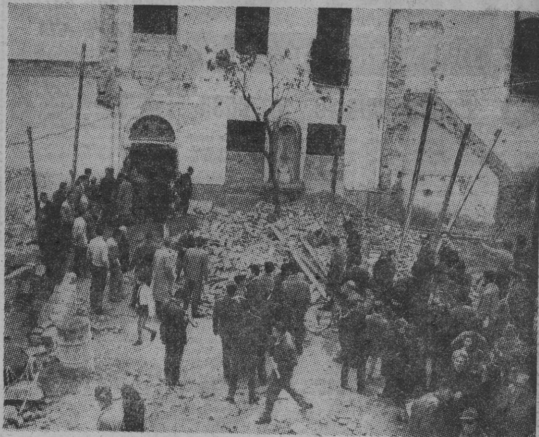
Un aspecto del lugar del derrumbamiento.
